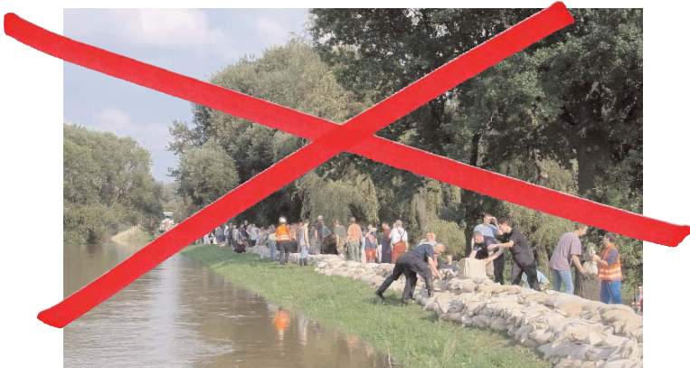
Hochwasserschutz mit Sandsäcken kostet viel Zeit, Aufwand und Manpower.
