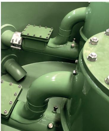
Die STRATE AWAguard® Beschichtung hat eine Korrosionsschutzwirkung der Kategorie C5-I und C5-M. Ein vergleichbarer Korrosionsschutz wird nur durch Edelstähle der Kategorie CRC IV (1.4462 Duplex/ Super Duplex; 1.4439 und 1.4539 Super Austeniti Stahl) erreicht.
