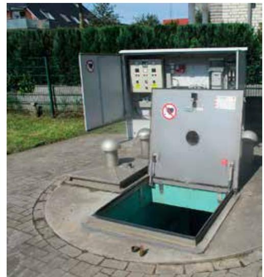
Pumpenschacht und Steuerungstechnik im Schaltschrank.
